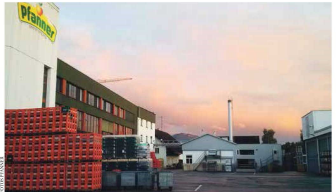
Pfanner erweitert den Stammsitz in Lauterach (Vbg.) um ein vollautomatisches Hochregallager
